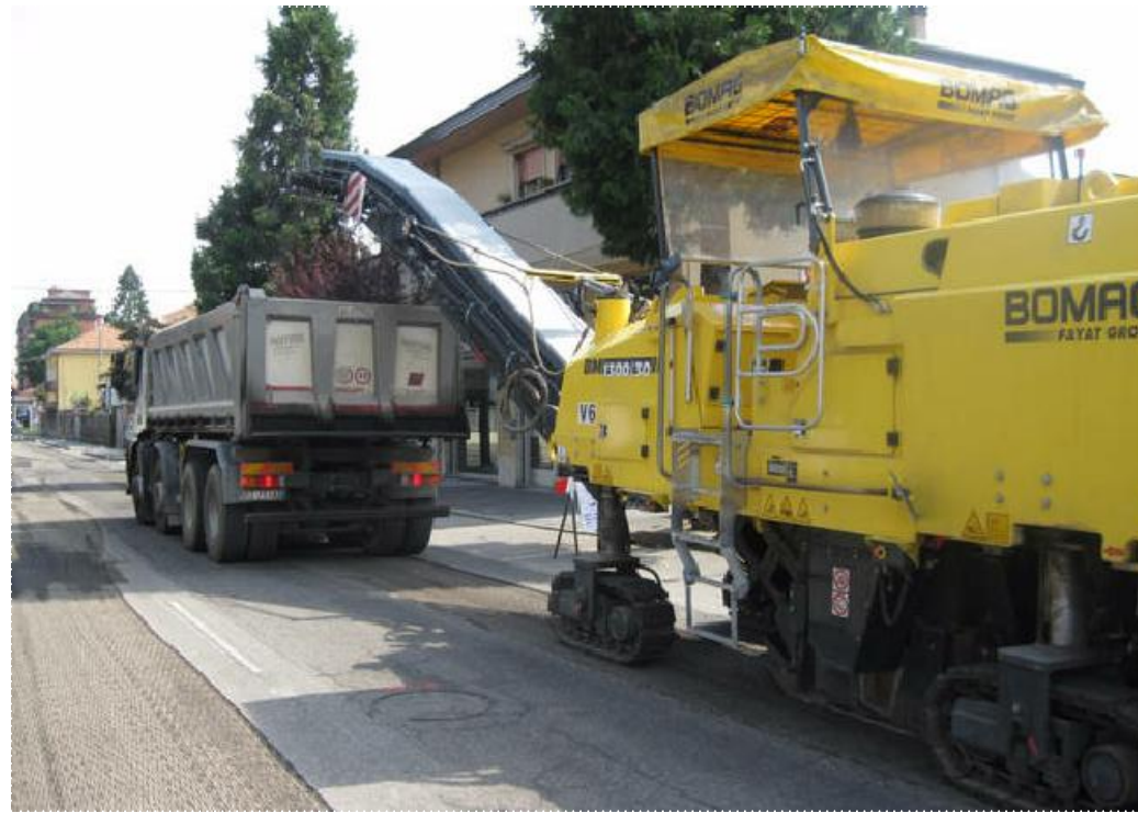
FRESATURA E RIMOZIONE DELLO STRATO DI USURA ESISTENTE E TRASPORTO IN DISCARICA
