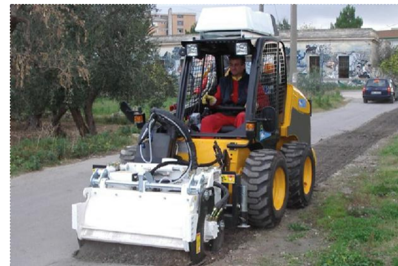
FRESATURA E RIMOZIONE DELLO STRATO DI USURA ESISTENTE E TRASPORTO IN DISCARICA
